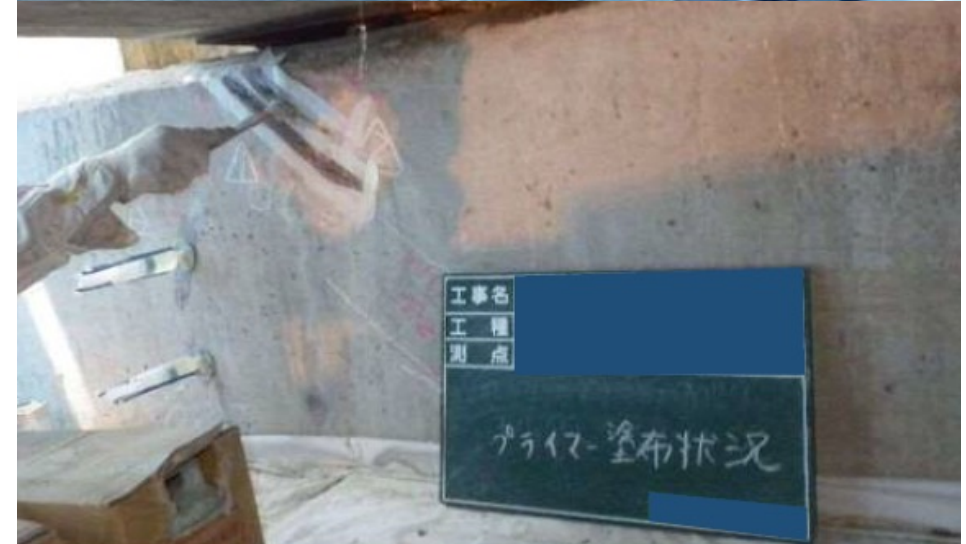
▲躯体補修（ひび割れ注入工法）
