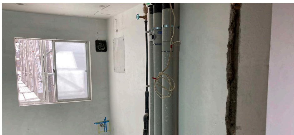
▲給排水管更新
