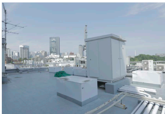
スカイテラス新設
