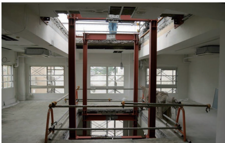
エレベーター新設
