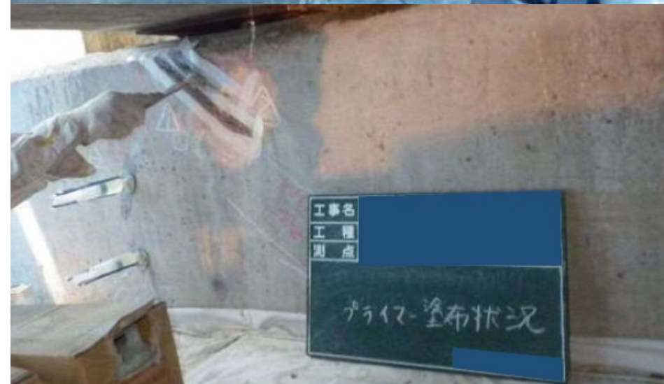
▲ 躯体補修（ひび割れ注入工法）
