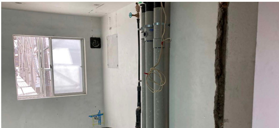
▲給排水管更新
