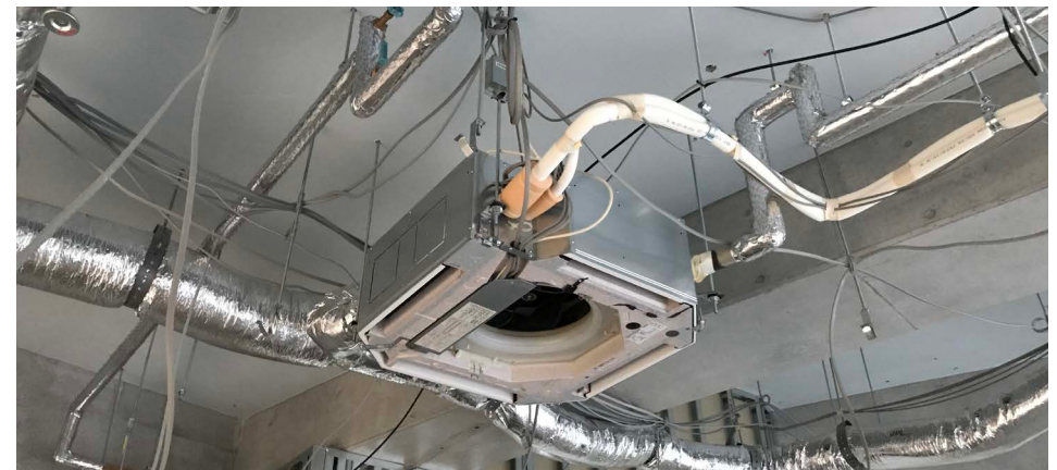
▲空調設備更新
