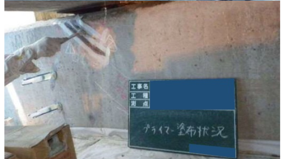
▲躯体補修（ひび割れ注入工法）
