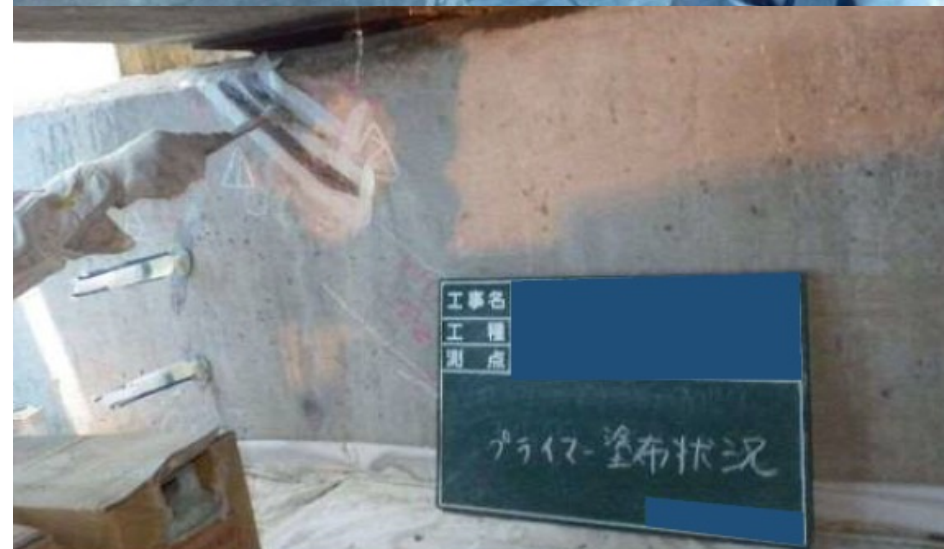
▲躯体補修（ひび割れ注入工法）
